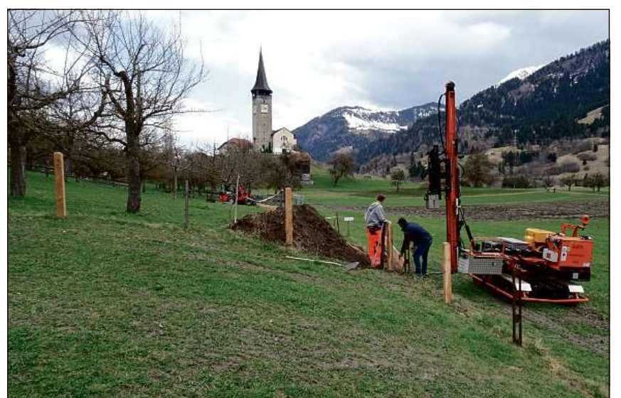
Las petgas ein vegnidas messas cun ina maschina speciala per far gardetschas
